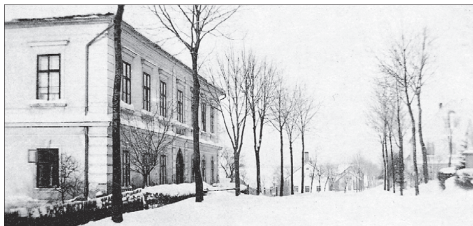
Budova školy po přestavbě v roce 1889 na dobové pohlednici
