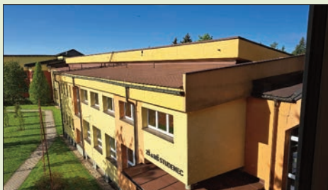
Nová střecha na budově A
