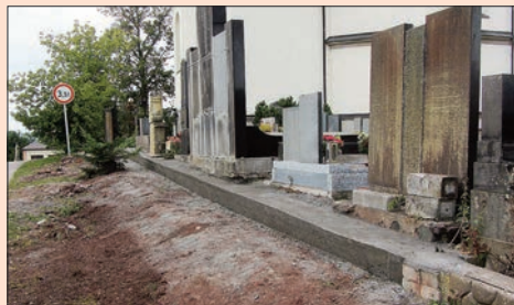
Oprava hřbitovní zdi
