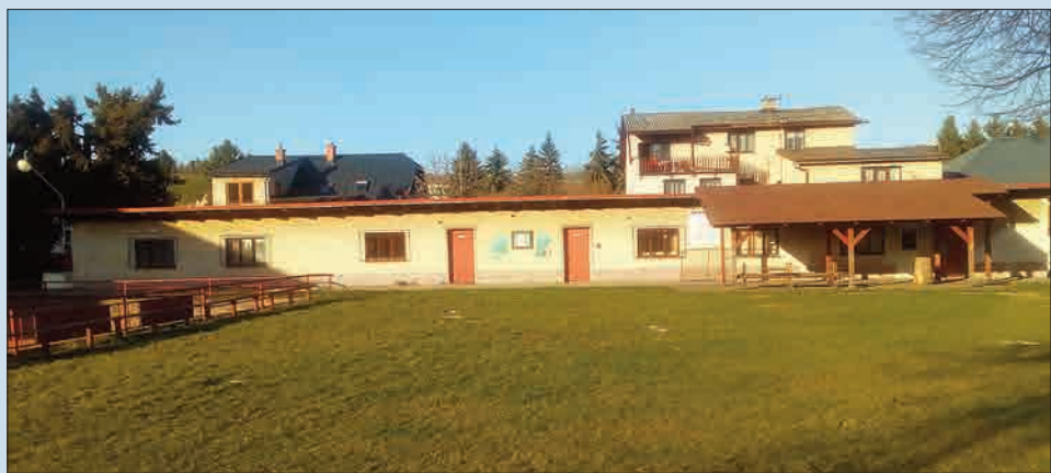
Kabiny před demolicí
