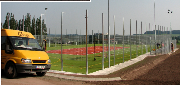
Stavba po dvou měsících (2. 7. 2012) – travnatý povrch, budování oplocení
