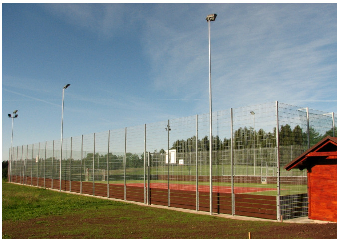
Stavba (19. 7. 2012) – téměř hotovo!
