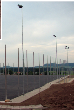
Stavba (19. 6. 2012) – asfaltový, vodě propustný podklad
