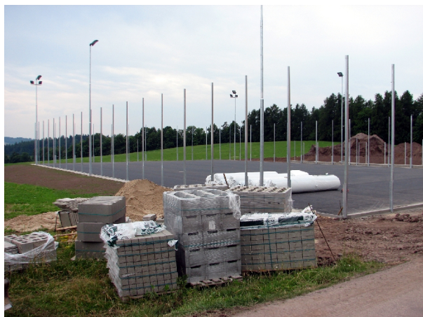
Stavba (19. 6. 2012) – asfaltový, vodě propustný podklad
