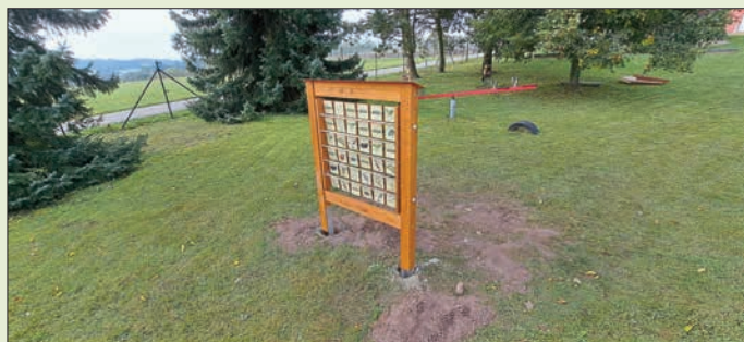
Instalace nového herního prvku
